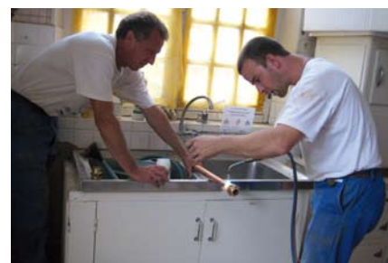
Raccord du réseau d'eau potable : Marc Guerin et Christophe Bourdon
