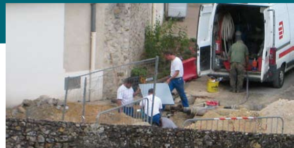
Réfection du réseau d'eau potable
